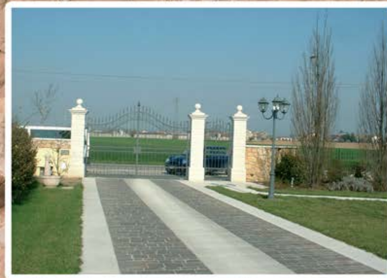
VILLA A SAN BONIFACIO, VERONA INGRESSO, ARCO E BALAUSTRATA IN PIETRA DELLA LESSINIA BIANCA LEVIGATA E SPUNTATA A MANO
