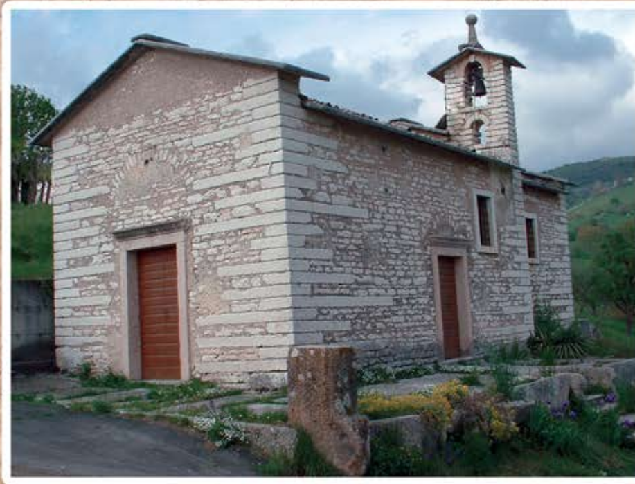
TIPICA CHIESA DEL 18° SECOLO IN LOCALITÀ ZIVELONGO DI SANT'ANNA D'ALFAEDO INTERAMENTE COSTRUITA IN PIETRA DELLA LESSINIA
