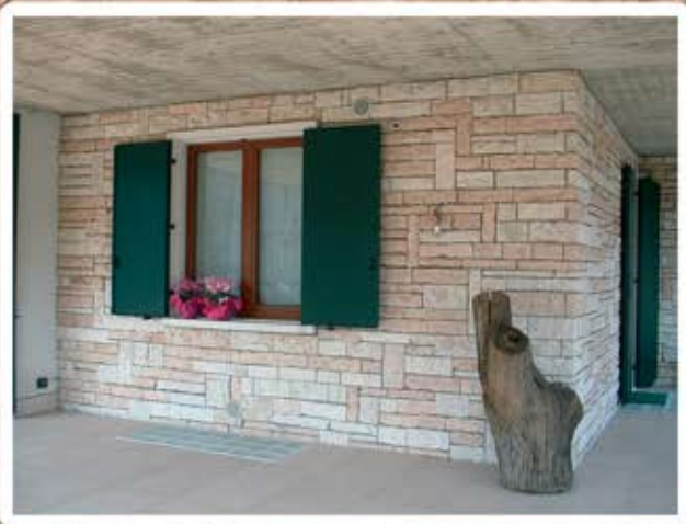
WANDVERKLEIDUNG UND SÄULE AUS BOSSIERTEN STEINEN. BODENBELAG AUS MATTGLÄNZENDEM ROSA NATURSTEIN.
