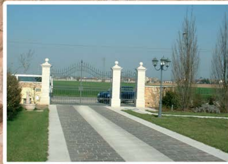
VILLA IN SAN BONIFACIO, VERONA. SÄULEN AUS WEIßEM NATURSTEIN MIT HANDGEFERTIGTEN ELEMENTEN. BOGEN UND BALUSTRADE AUS WEIßEM UND GESCHLIFFENEM NATURSTEIN
